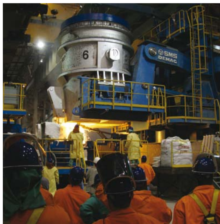
PSI Kollegen live vor Ort beim ersten Abguss am Caster. Mittelfristig produziert SeverCorr 1,5 Mio. Tonnen Stahl pro Jahr.
