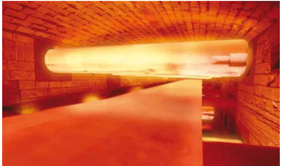
Glühofen bei ThyssenKrupp Electrical Steel: Hier erhalten die neuen Werkstoffe für Elektromotoren ihre besonderen Eigenschaften. Quelle: ThyssenKrupp
