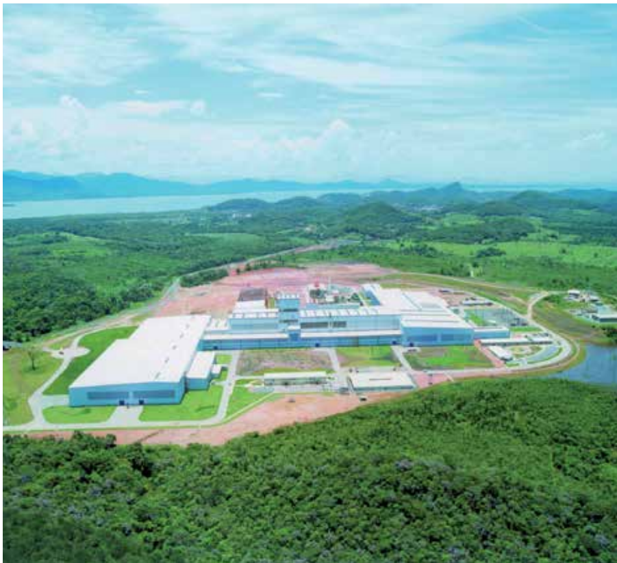
ArcelorMittal Vega produziert im Werk São Francisco do Sul (Brasilien) Flachstahl durch Kaltwalzen, Beizen und Galvanisieren.
